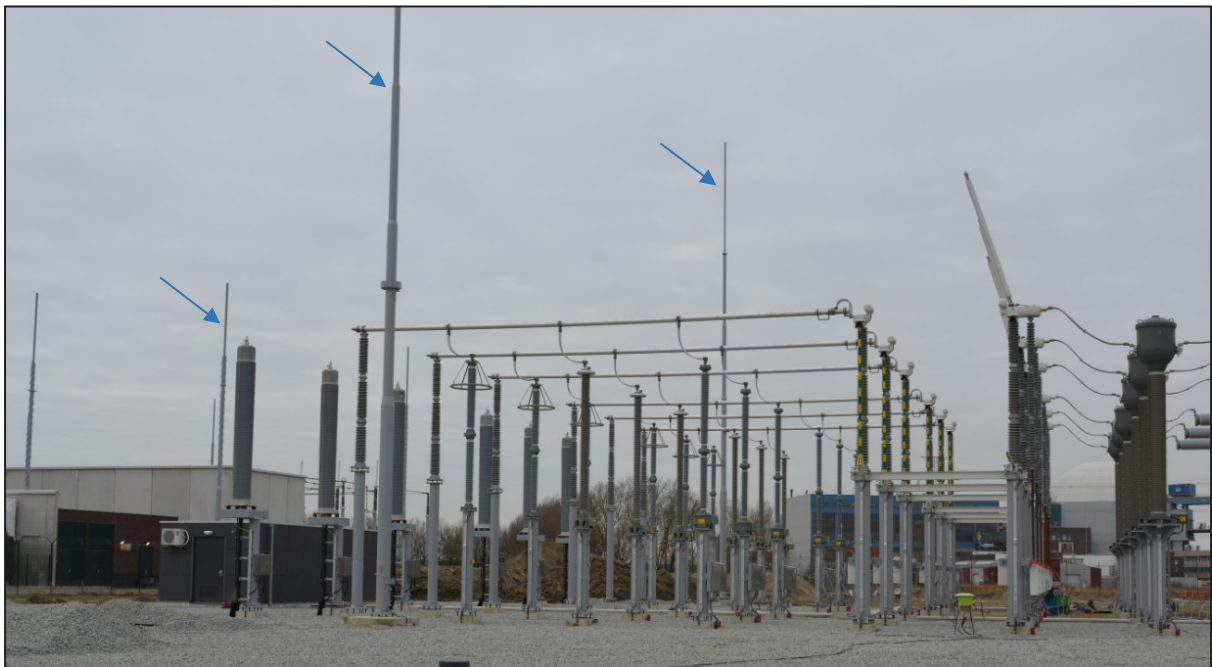
Figuur 1 – Bliksempieken op een hoogspanningsstation (eigen gemaakte foto)
